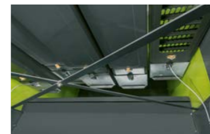
Kohlinten päädyssä olevat huoltoaukot mahdollistavat nopean käsiksi pääsyn ilman työkaluja.
