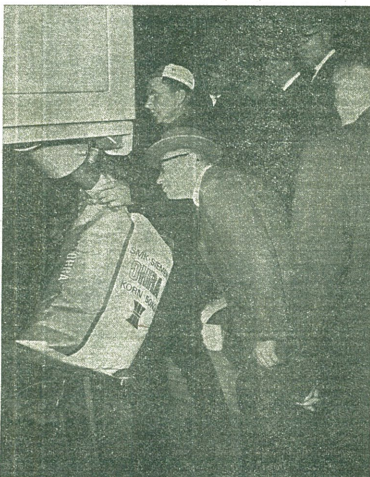
Kutsuvieraat tulustuivat myös laitoksen toimintaan. Kuvassa venttiilisäkkien täyttö käynnissä.
